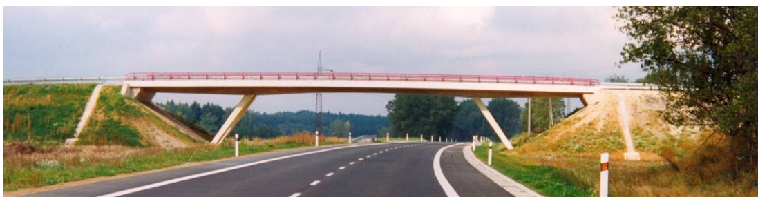
Obrázek 69 - Monolitický předpjatý rámový integrovaný most na obchvatu Chebu [8]
