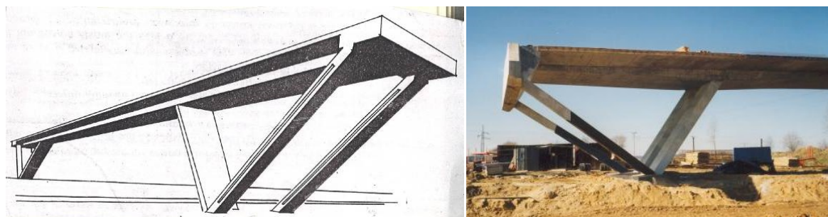
Obrázek 61 - Příklady uspořádání předpjatých rámových mostů se šikmými stojkami [7]
